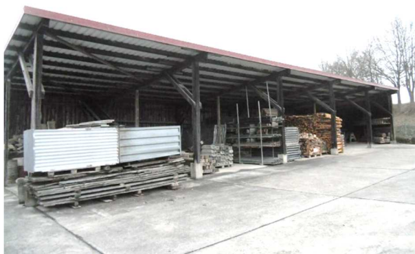
Bild 5: Baustoffhandel, nördl. Hofbereich
