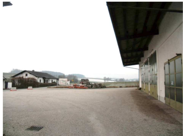
Bild 4: Baustoffhandel, südl. Hofbereich
