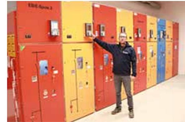
Stadtwerke-Elektromeister Stefan Wirthmüller begleitet die Planung und den Bau des Schalt hauses 2. Die roten und gelben Mittelspannungsschaltfelder versorgen das Stromnetz der Stadtwerke. Im blauen Mittelspannungsschaltfeld ist die Verbindung zum Umspannwerk der Bayernwerke.
