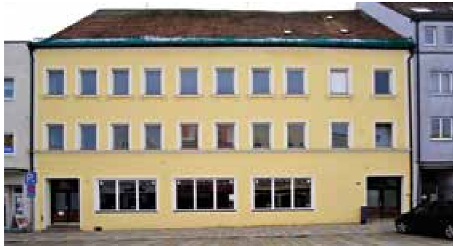
Der frühere Brauereigasthof Haslbeck wird zu einer modernen Musikschule umgebaut.
