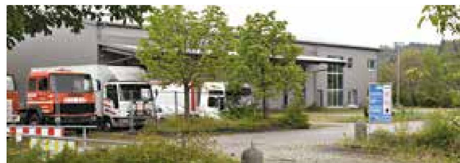
In dieser Montagehalle an der Fronthenhausener Straße will ein Investor aus Moosburg Zimmer für 201 Geflüchtete einrichten.
