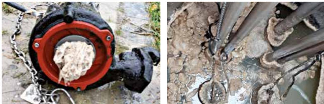
Feuchttücher im Abwasser führen zu schwerwiegenden Schäden an den Pumpen. Rechts: Fette verstopfen Pumpen und Rohrleitungen.
