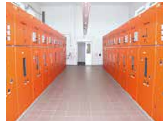
Schalthaus, Stadtwerke Vilsbiburg
