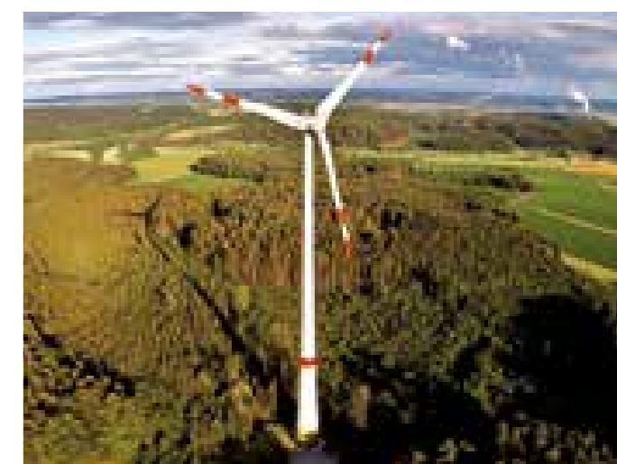
Windrad der Stadtwerke Vilsbiburg in Moosthann
