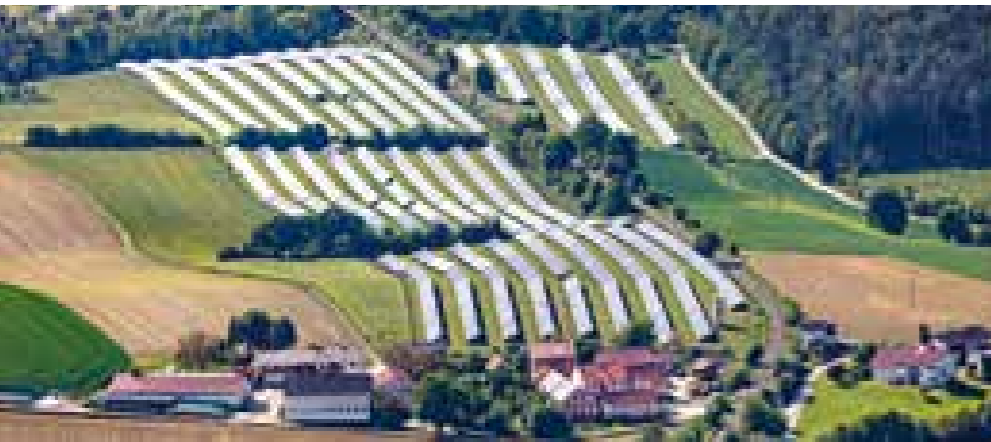
Das Bürger-Solarfeld vor den Toren der Stadt deckt rund 10 Prozent des gesamten Strombedarfs der Stadt
